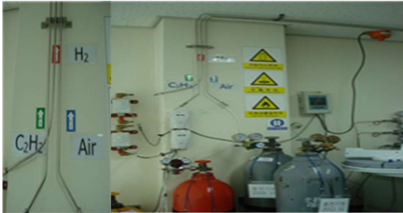
가스의 종류 및 흐름방향 표시 적정
