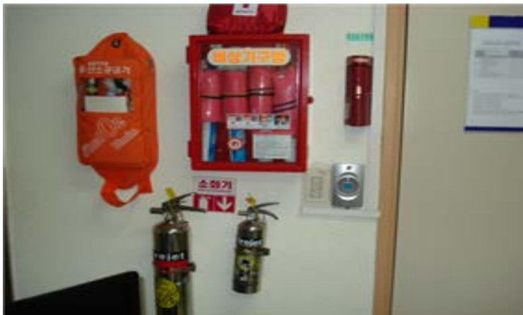
출입구에 소화기 및 비상조명 등 설치(자연대)
