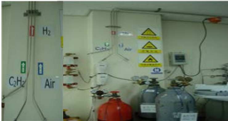
가스의 종류 및 흐름방향 표시 적정
